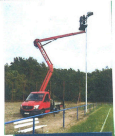
Die Leuchtmittel werden installiert
